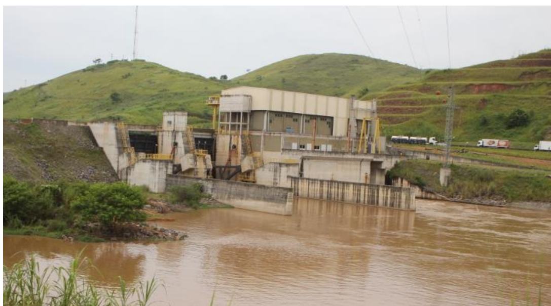
Figura 1. Barragem Lavrinhas, vista a jusante. Fonte: Fractal Engenharia (02MAR2016 – IMG_1646).
